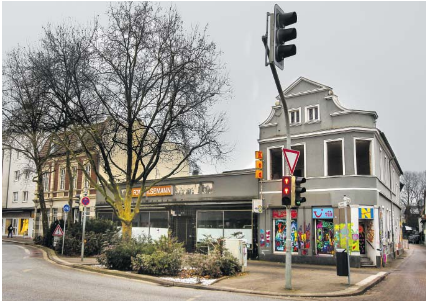
Gescheitert: Auf dem Gelände von Foto Isemann und dem rechts daneben stehenden Gebäude ohne Fensterglas wollte die Lebenshilfe bauen.
